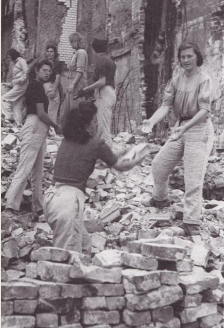
Quelle: Bremen nach der Stunde Null : Bilddokumente aus d. Jahren 1945-1960/ Georg Schmidt-Bremen, Schünemann, 1983 Trümmerfrauen und Steinherstellung aus Bauschutt
